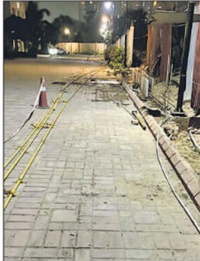
गुरुग्राम के सेक्टर-104 की सोसाइटी में पीएनजी लाइन बिछाने का कार्य किया जा रहा है। • फाइल फोटो
